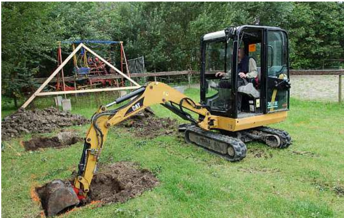
Ein Minibagger hilft beim Gartenhaus Fundament und macht Spaß.
